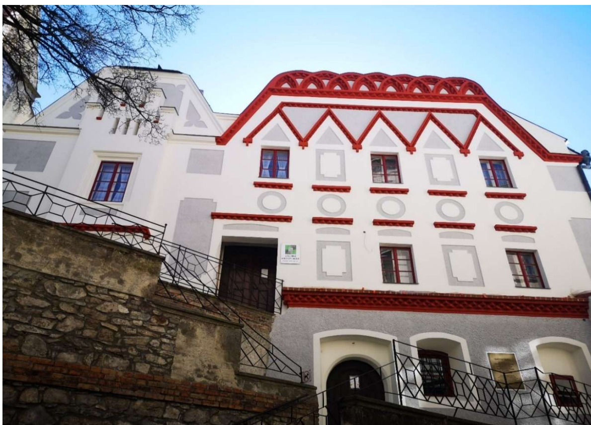
S využitím finančního příspěvku z Programu regenerace městské památkové rezervace byla obnovena severní fasády historického objektu základní umělecké školy v Kostelní ulici.
